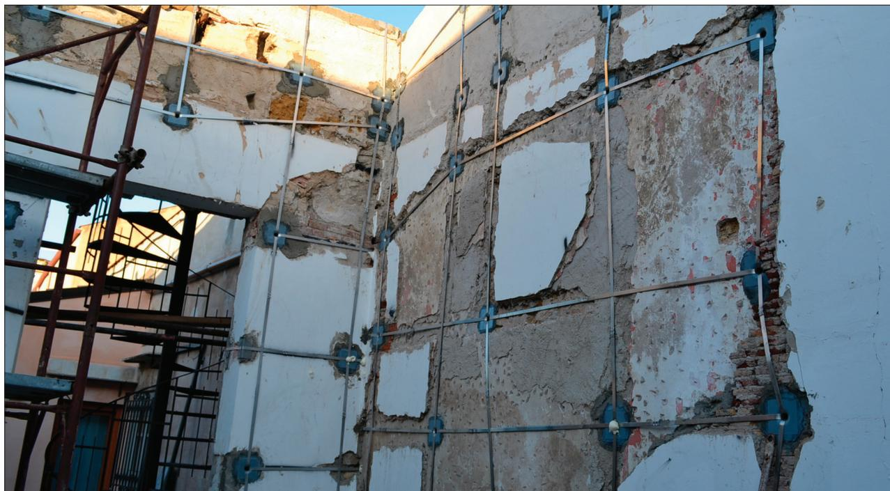
Ex Collegio di San Rocco, Palermo – Consolidamento pareti con sistema CAM, messa in sicurezza capriate con sistema a funi di acciaio e barre Dywidag
